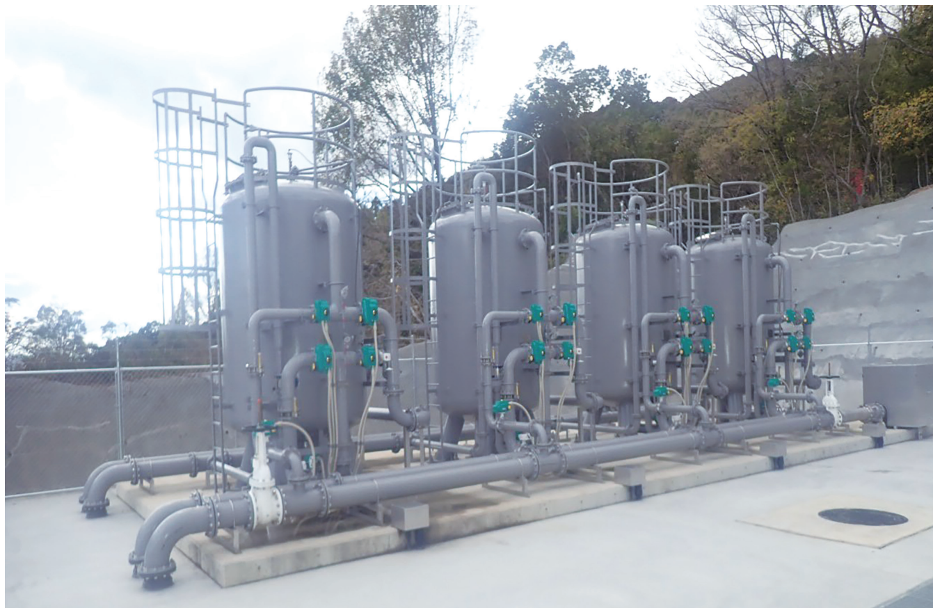
上川口浄水場(建物上部の円柱4基が急速ろ過機)
