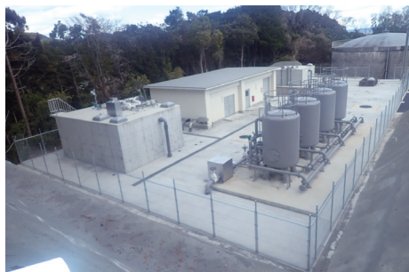
上川口浄水場(建物上部の円柱4基が急速ろ過機)
