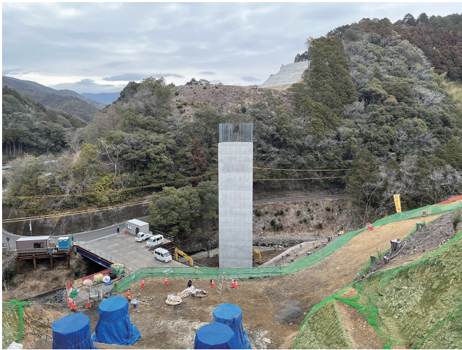
町道を跨ぐ小黒川大橋（仮称）
