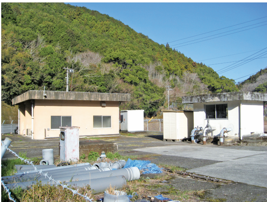
上川口上水道取水施設
