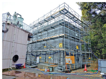
工事中の衛生センター
