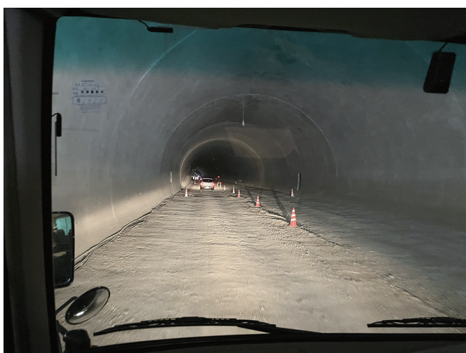
舗装前の不破原トンネル（仮称）内を走行
