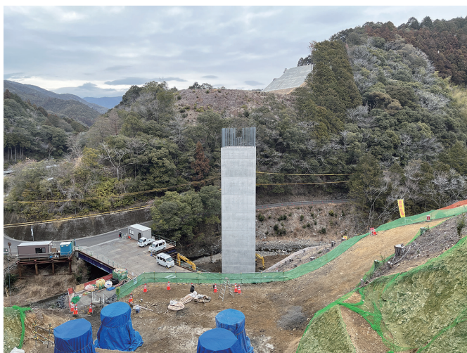
町道を跨ぐ小黒川大橋（仮称）
