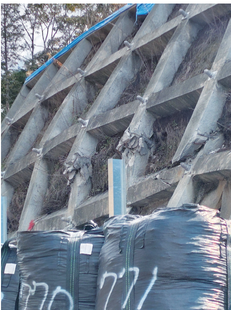
町道大井川馬荷線改良現場
