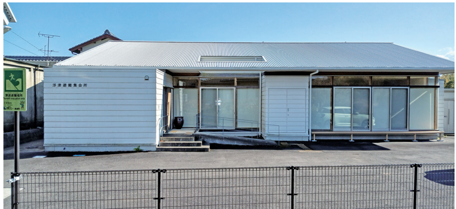
令和元年移転新築の浮津避難集会所
