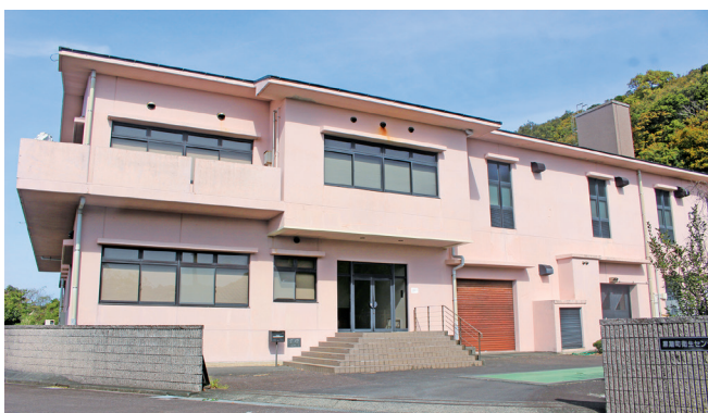
井ノ岬に建つし尿処理施設「黒潮町衛生センター」(灘)
