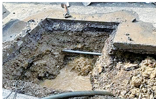
水道管漏水と修繕工事現場
