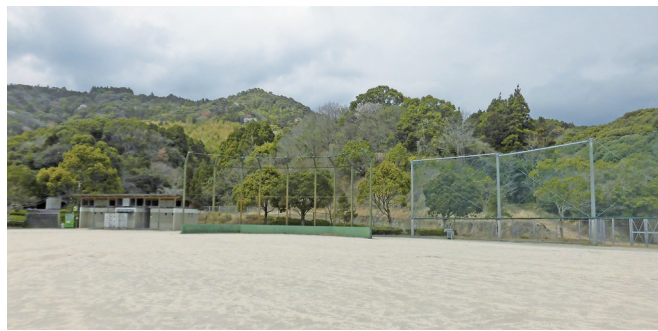
背後の県所有地の土を運動場へ投入嵩上し津波避難場所にも活用
