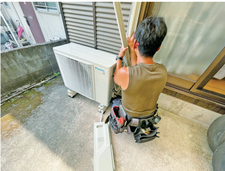
省エネ家電取り付け工事の様子(令和7年7月)
