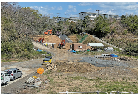
防災減災対策ため池工事（令和7年3月、入野芝）
