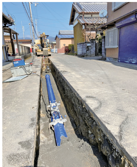
更新に併せて耐震化を進める水道管工事（令和7年2月下旬、入野早咲）
