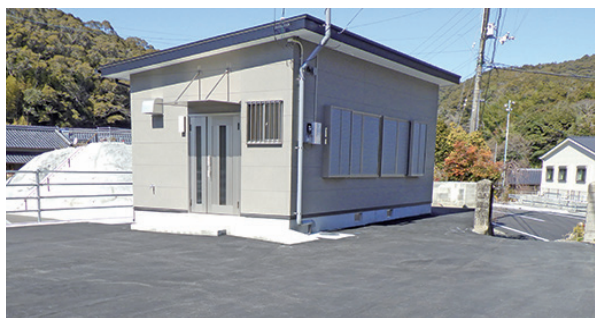
完成した小黒ノ川集会所
