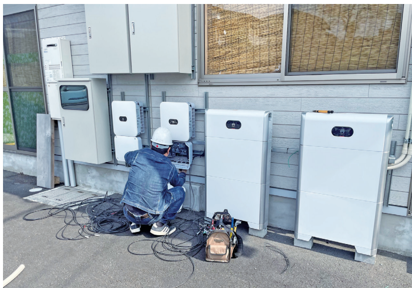
太陽光パネル設置後、蓄電池の設置工事 (令和7年3月、あったかふれあいセンターにしきの広場)
