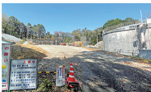
工事中の現場（中央奥） (令和7年4月、上川口浄水場)
