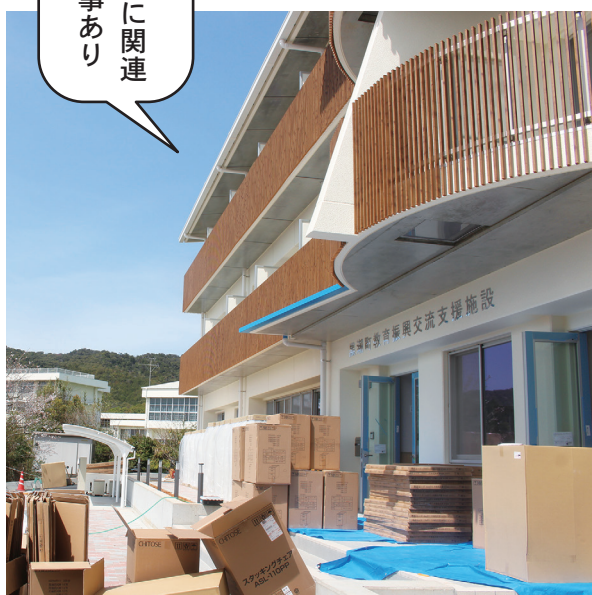
入居準備が進む大方高校側に建設の教育振興交流施設(手前、令和7年3月30日)
