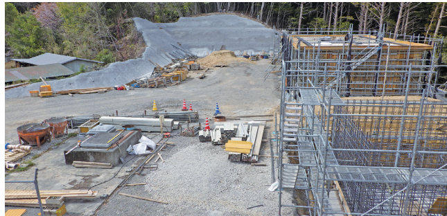
工事中の浄水場 (令和7年3月下旬、上川口)
