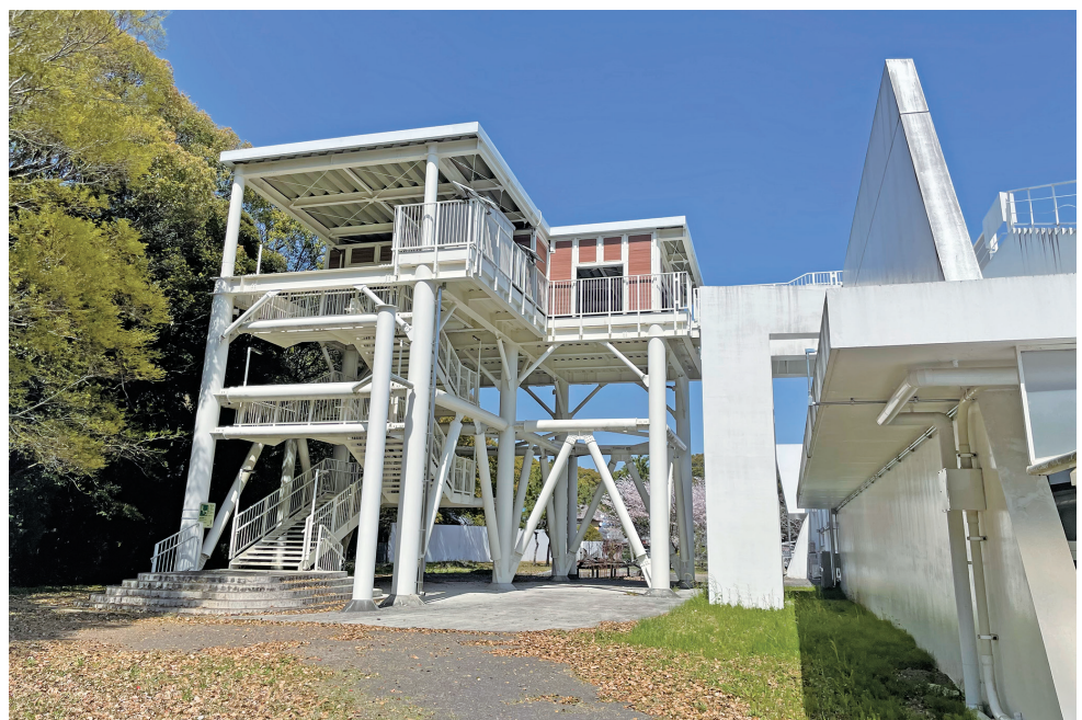
一次避難所の大方あかつき館横の避難タワー
