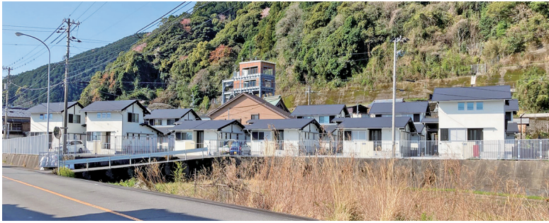
令和6年度に整備された町営住宅（横浜）
