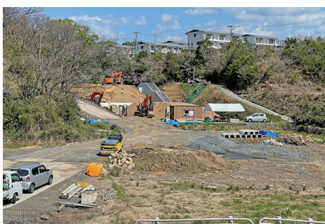
防災減災対策ため池工事（令和7年3月、入野芝）
