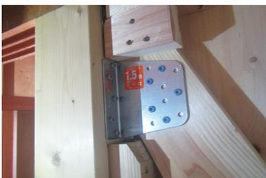
耐震工事の一例 (接続補強盤)
