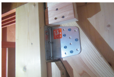
耐震工事の一例(接続補強盤)
