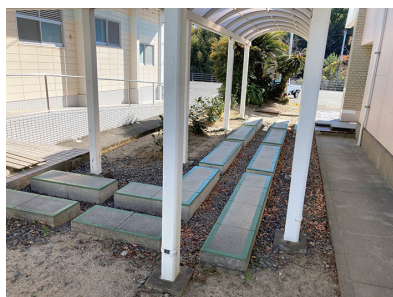
修繕予定の校舎から体育館への通路(令和7年1月上旬、大方中学校)
