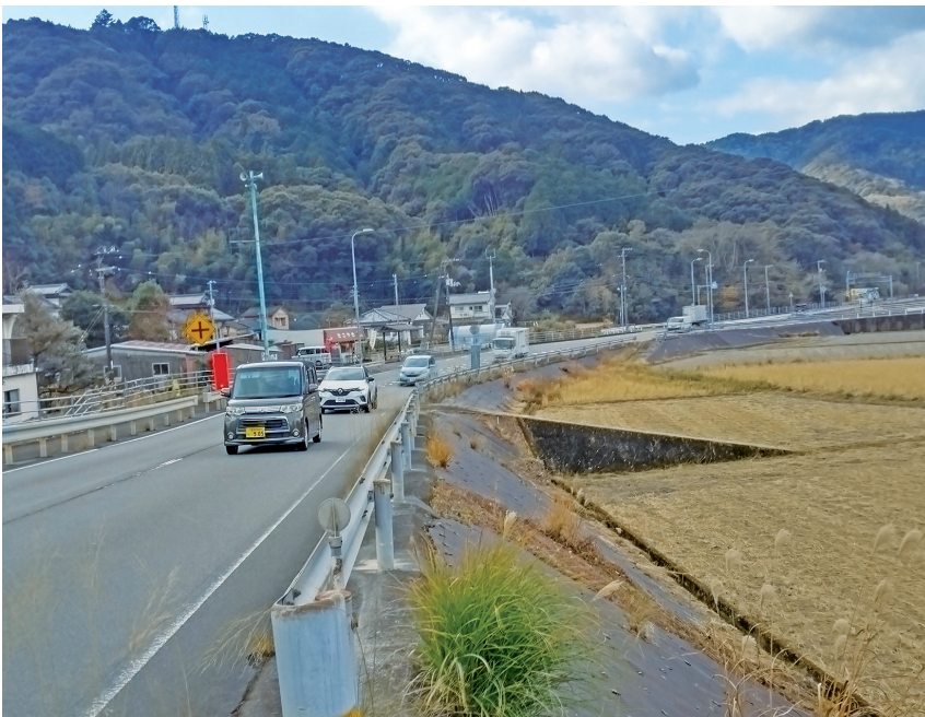
安全対策が急がれる不破原の道路
