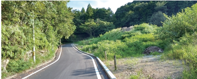
町道成又熊野浦線の拡幅工事済み箇所 （令和6年9月）
