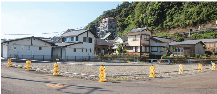
更地状態の建設予定地 (令和6年10月1日、横浜)
