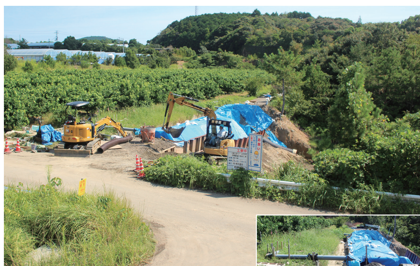
農道と水道管の被災現場。 右は、応急措置中の迂回水道管 （令和6年10月1日、ヤモウジ団地）
