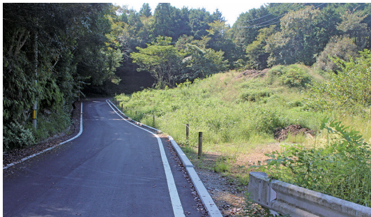
成又熊野浦線の道路拡幅部。右側は残土を入れてある場所（令和6年10月）
