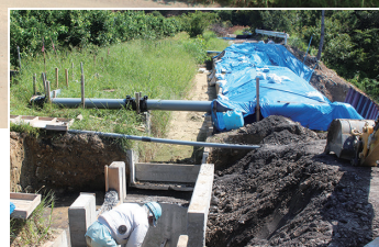
農道と水道管の被災現場。 右は、応急措置中の迂回水道管 （令和6年10月1日、ヤモウジ団地）
