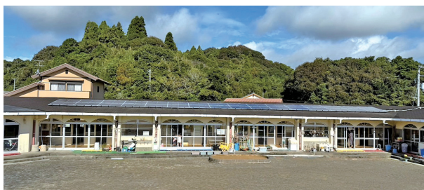
屋根に設置された太陽光パネル（南部保育所）
