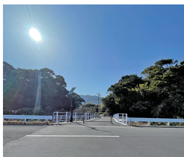
完成した避難路（明神地区）
