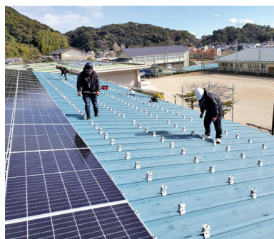
佐賀小学校屋上
