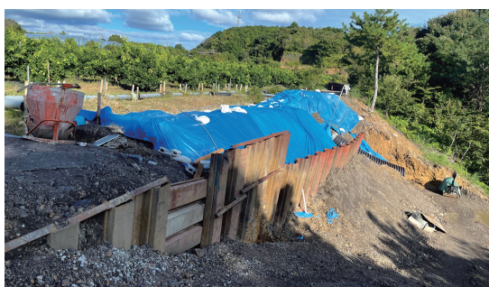
配水管災害復旧現場 (令和6年10月6日、 ヤモウジ団地)
