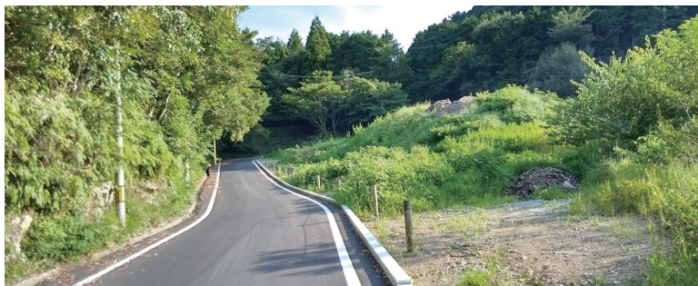
町道成又熊野浦線の拡幅工事済み箇所
