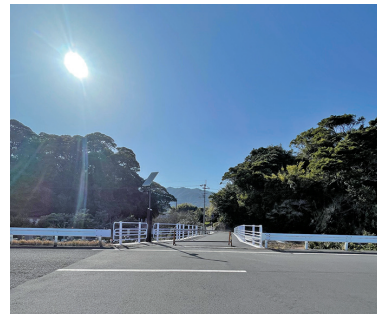
完成した避難路（明神地区）
