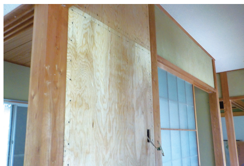
構造用合板による補強
