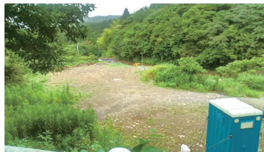
成又熊野浦線の改良工事 （令和6年6月）
