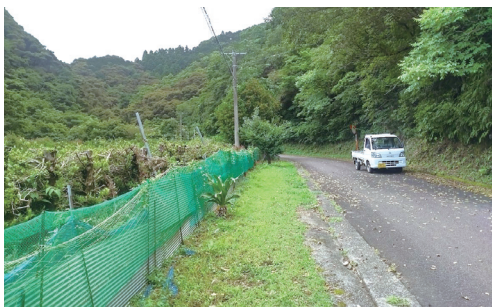
熊野浦海岸線改良（避難 道路）（令和6年6月）
