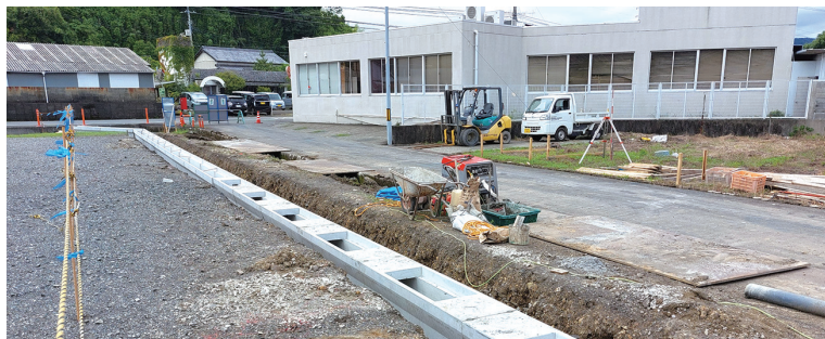
整備中の通学路（町道田端支1号線）
