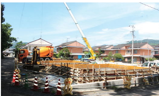
建築工事が進む浜松更新住宅(令和6年7月3日)
