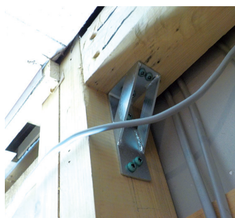
補強金具の施工例 （右2枚）
