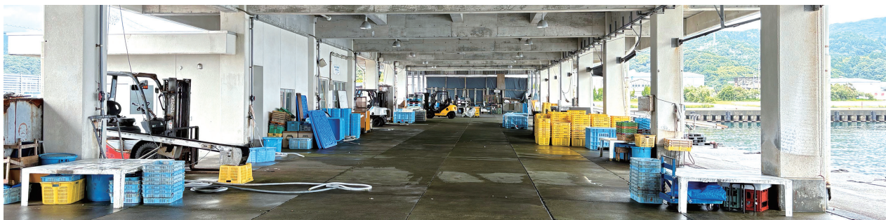
佐賀漁港荷捌所 (令和6年6月28日)
