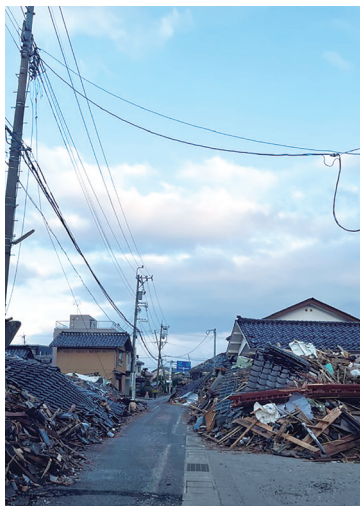
家屋が倒壊した珠洲市の様子 (令和6年1月)
