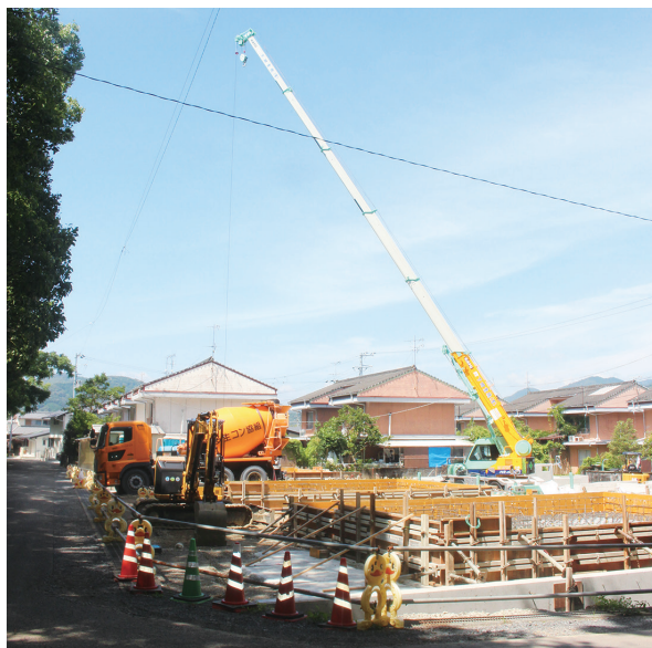
整備工事が進む浜松更新住宅（6年7月3日、入野）
