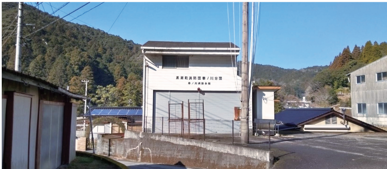
黒潮町消防団拳ノ川分団屯所（令和6年2月12日）
