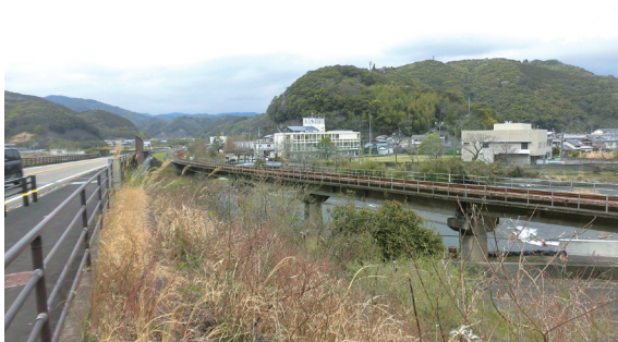
地震津波で被災が想定される佐賀庁舎
