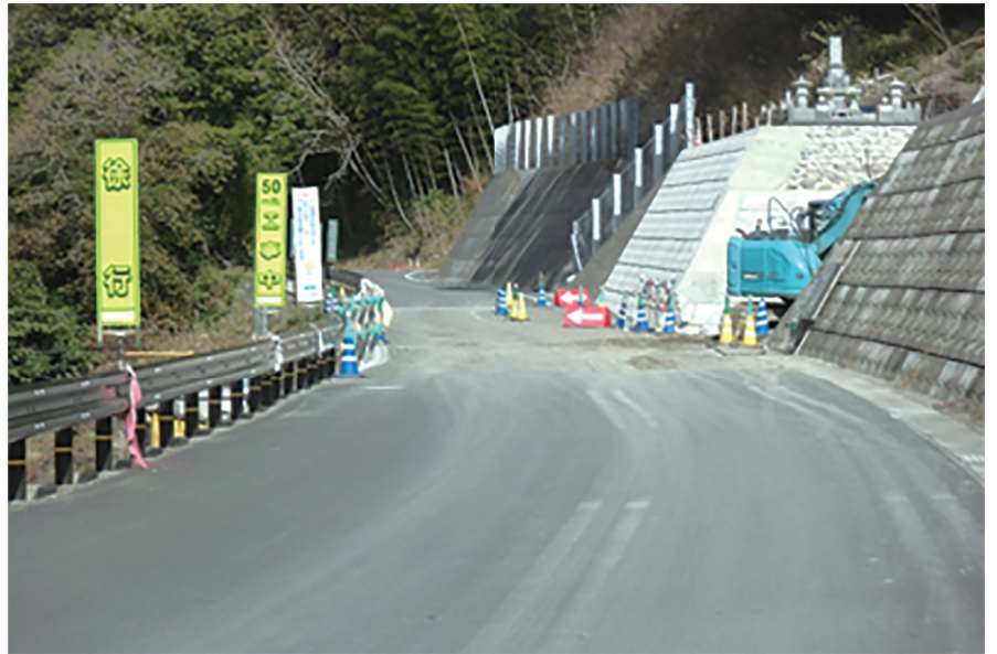
改良工事实施中の町道湊川線（令和5年12月）
