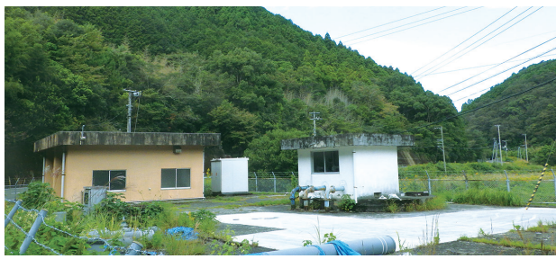
上川口の水源地。左側が機械室、右側の白い建物が令和4年度に排泥管の設置と、ポンプ配管の取り直しを行った水源井戸とポンプ室(上川口取水設備)
