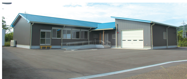
消防屯所と合築の早咲避難集会所(左側)
