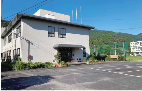
黒潮町総合センター（右奥には佐賀庁舎）
