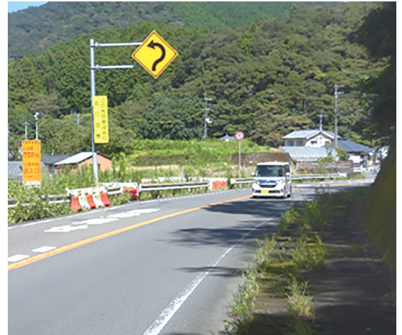
国道56号線 小黒ノ川大カーブ視距改良
