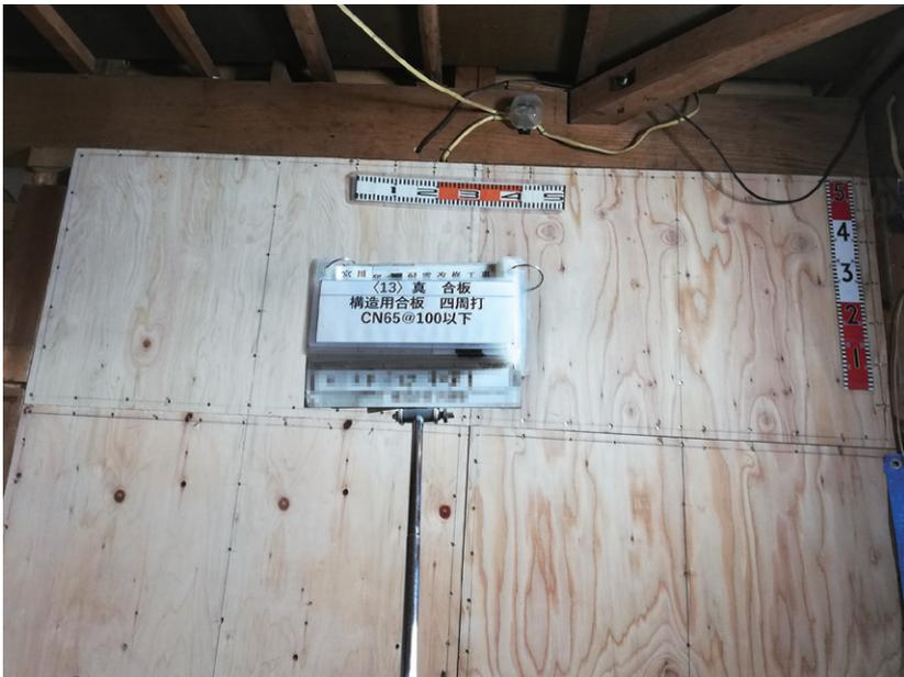
構造用合板による耐震補強工事
