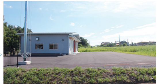
⑥ 上川口消防屯所 (令和5年3月)
