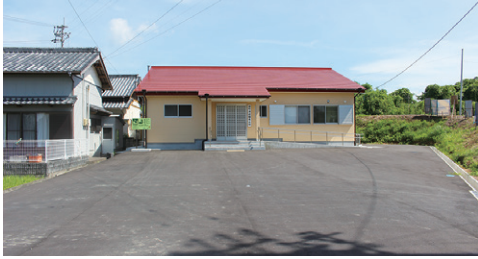
② 浮津避難集会所 (令和2年3月)
