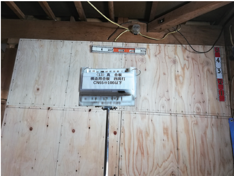
構造用合板による耐震補強工事
