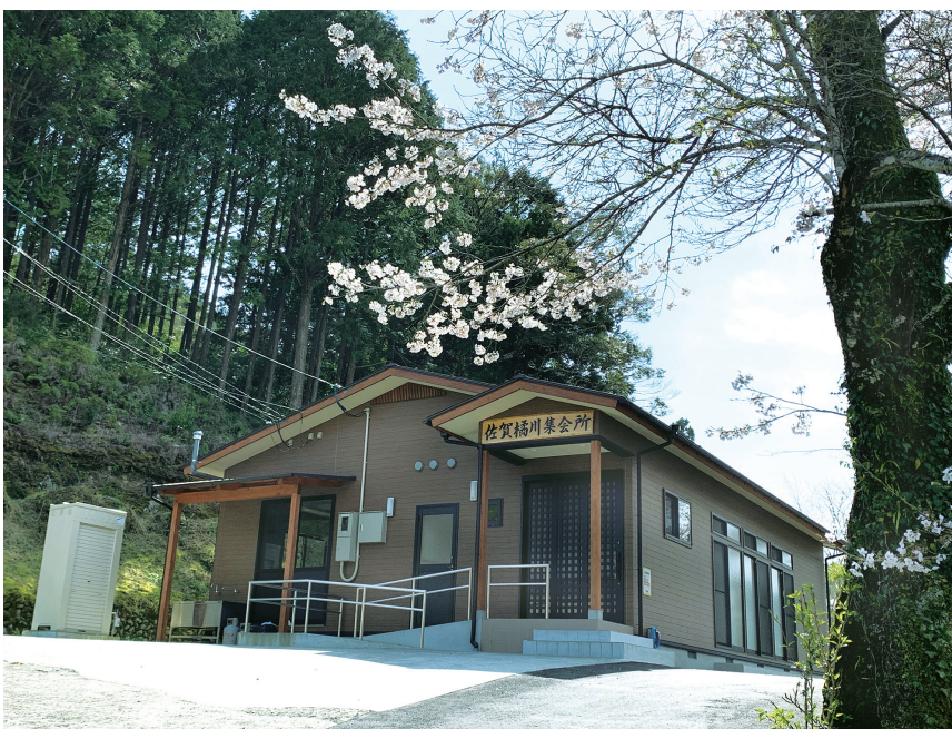
周辺の舗装工事も完了した佐賀橘川集会所
