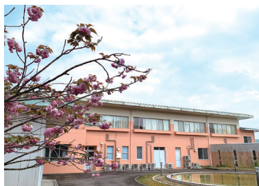
耐震改修した介護医療院ことぶき
