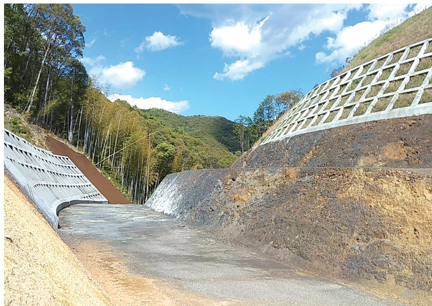
工事中の町道大井川馬荷線
