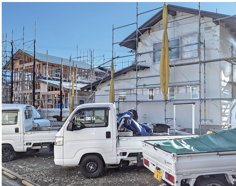
建て替え中の改良住宅（横浜地区）
