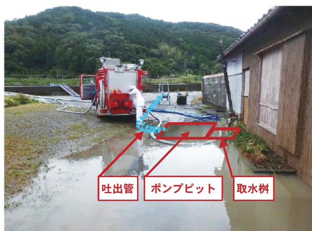
冠水時の様子（町分地区）
