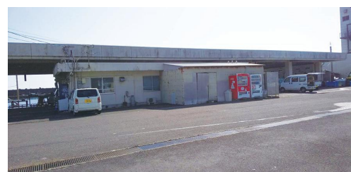
プレハブトイレ設置場所（佐賀港市場）
