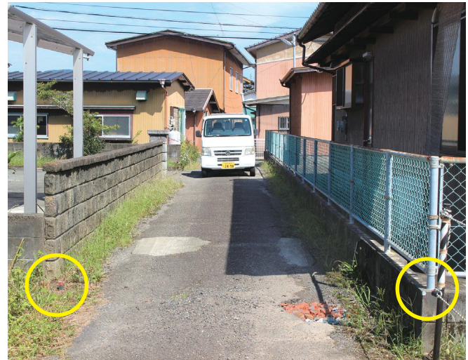
町道～町道を結ぶ 70m弱の公衆用道路の一部。道路のセンターまでが左右の宅地所有者名義の私有地となっている。黄色○印内は宅地と道路との境界杭（入野早咲）
