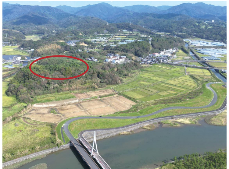
上空より松原大橋、弘野を望む (赤枠内は弘野避難所開設可能箇所、ドローン空撮)
