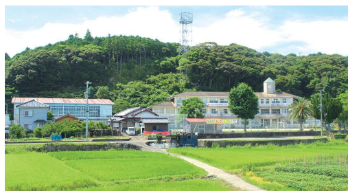
屋根などの改修予定の南郷小学校
