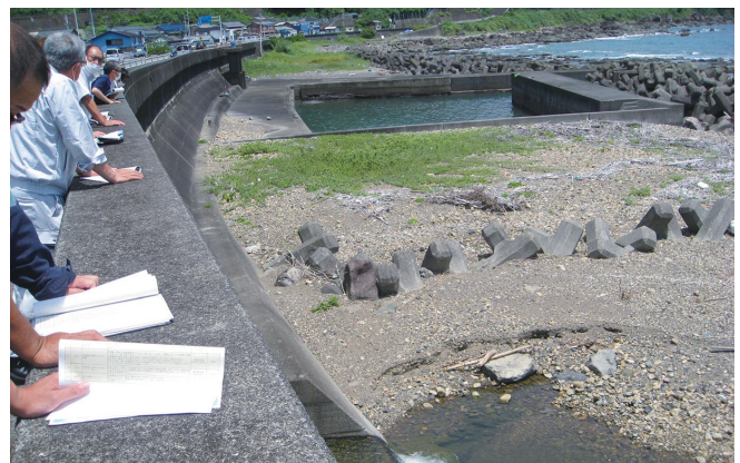
台風の時など、波が堤防の内側まで遡上してくるため、防潮扉の設置(手前)と消波ブロックの嵩上げを要望(白浜)
