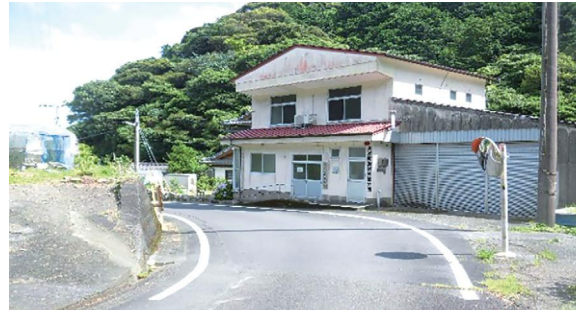
耐震が急がれる 鈴診療所・消防屯所
