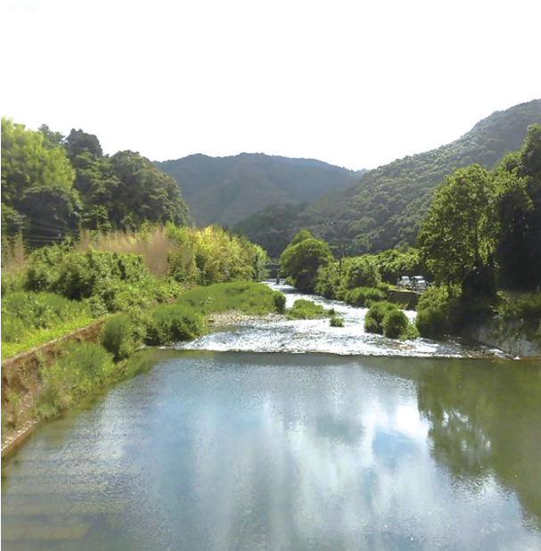
頭首工の下流右岸に放水口、左岸に堆積土砂と葦
