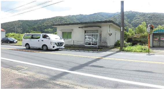
耐震・トイレの水洗洋式化 が急がれる伊与喜診療所
