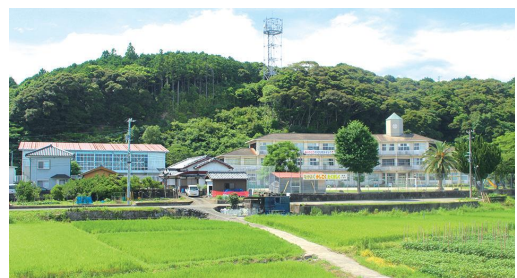
屋根などの改修予定の南郷小学校
