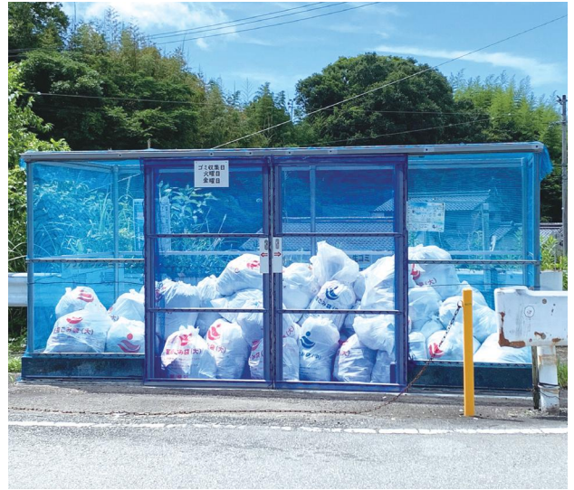
カーテン式から引き戸式に修繕された収納庫 (出口地区)
