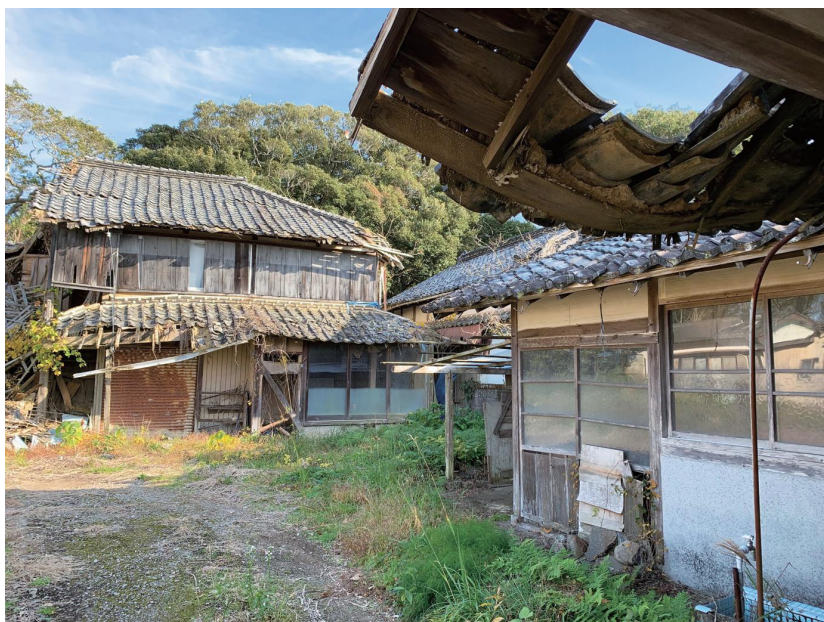
補助金を活用し、撤去された老朽住宅
