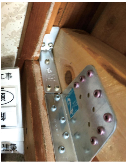
補強用金具で各部材を固定して強度は格段にアップ
