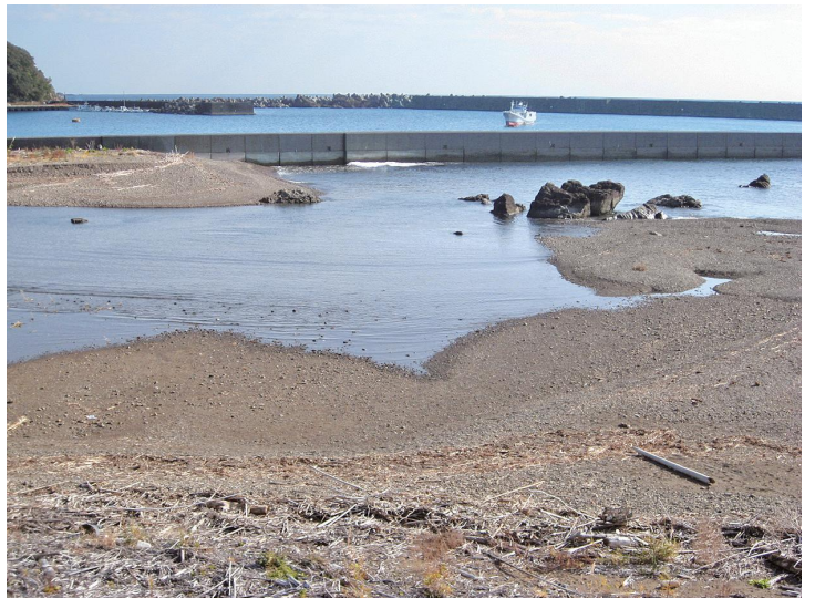
山からの土砂の流出で、狭小となった蜷川の河口 (上川口漁港の西側、令和3年12月13日)
