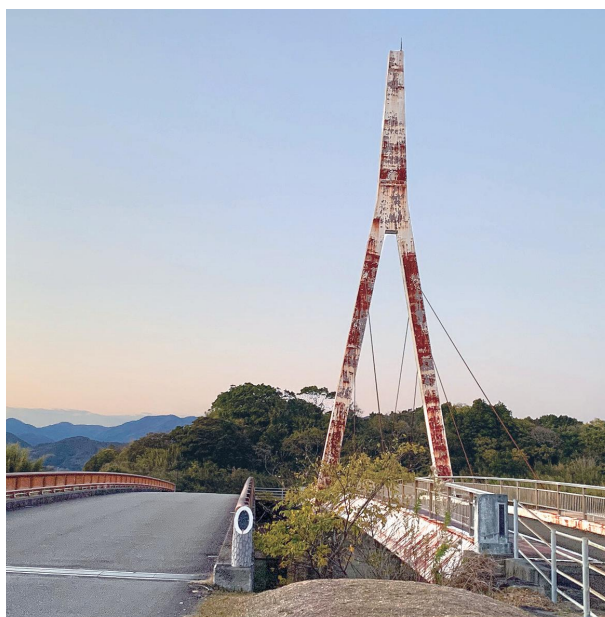
修繕計画が進む松原大橋を海側から望む
