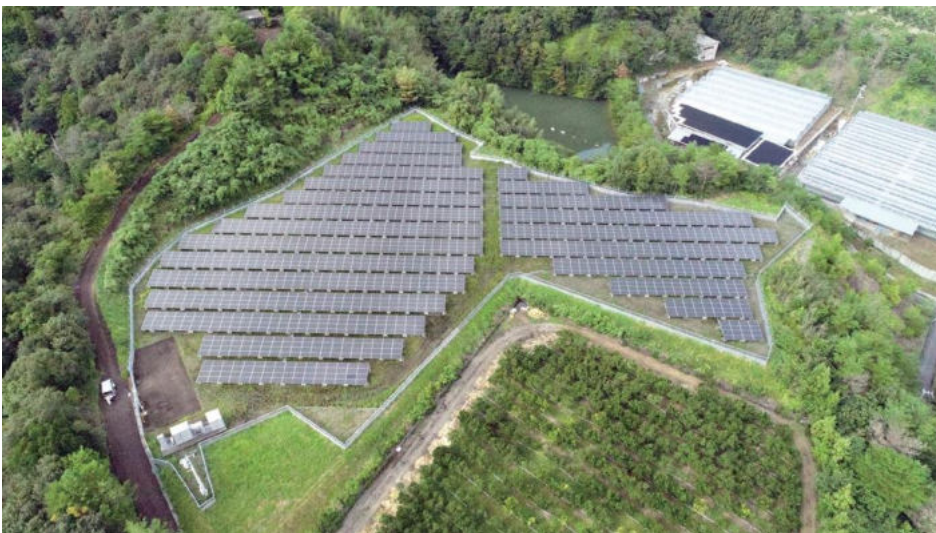
再生可能エネルギーの一つ 太陽光発電施設 (こうち・くろしお太陽光発電(株))
