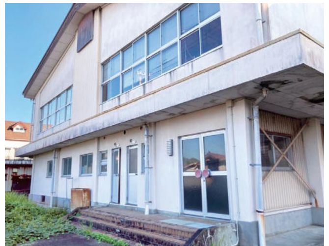
トイレ改修予定の伊田ふれあいセンター (旧伊田小体育館)
