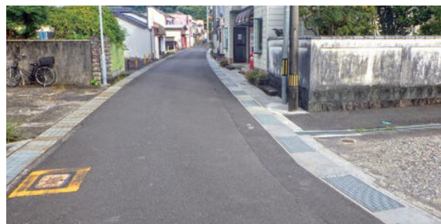
町道佐賀小町尾線側溝修繕工事（地域整備事業）
