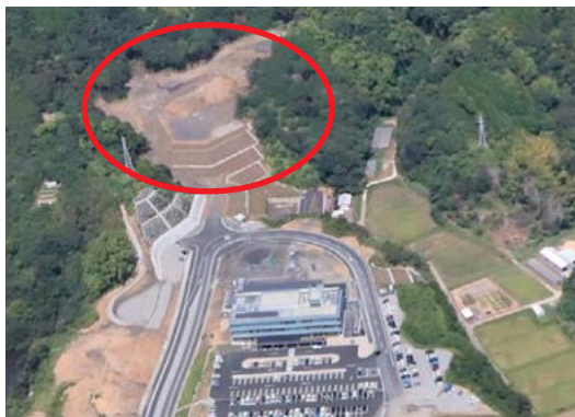
本庁舎北側、赤枠内が防災広場
