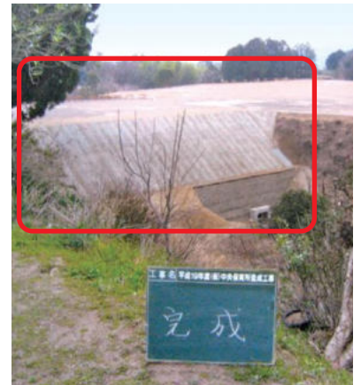
大方中央保育所造成工事 赤枠内が盛土部分 (平成 19 年度)
